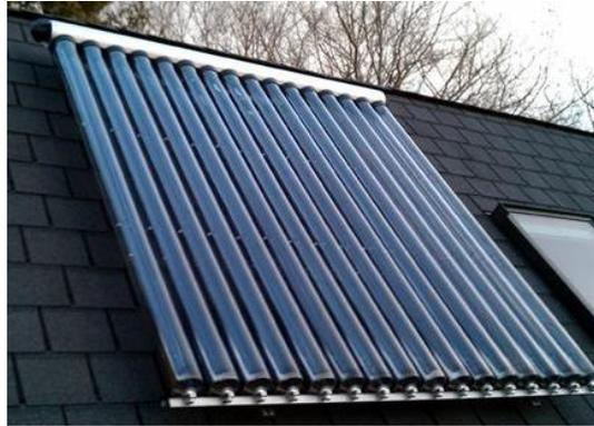
Figura 4.4. Instalación de captador con tubos al vacío (ETC). (2021). <https://vilssa.com/tubos-solares-de-vacio-energia-solar-termica>
